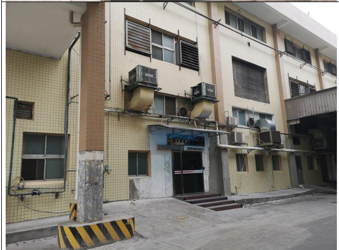
附图 8 厂区封闭隔声措施
